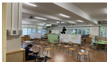
PFI 事業作業写真
