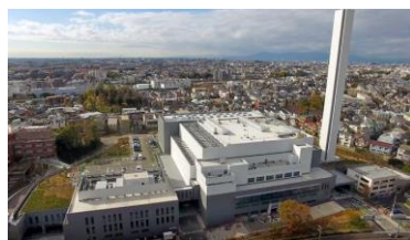
橋処理センター外観
